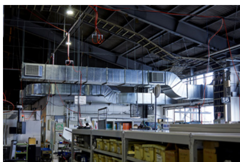
太陽光パネルで発電した電力で 工場内を冷却して作業環境を改善
